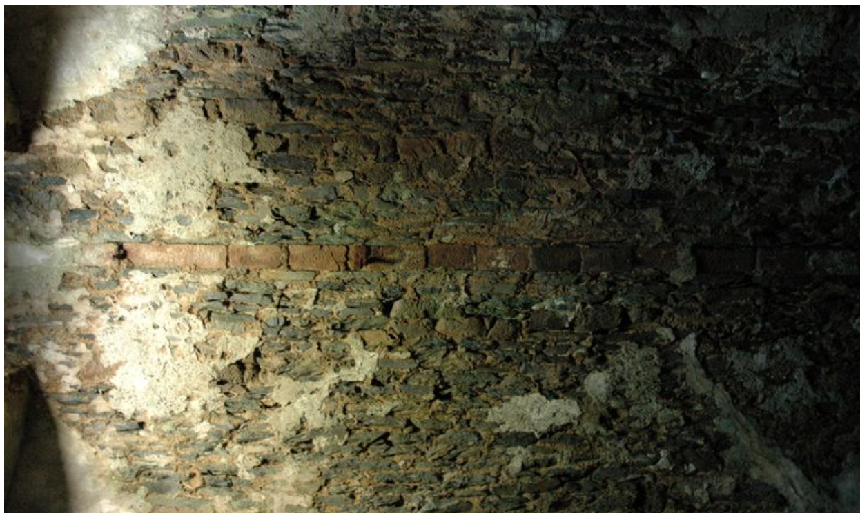
Vue de la redoute, réduit de l'île aux Moines : clé de voûte du casernement
