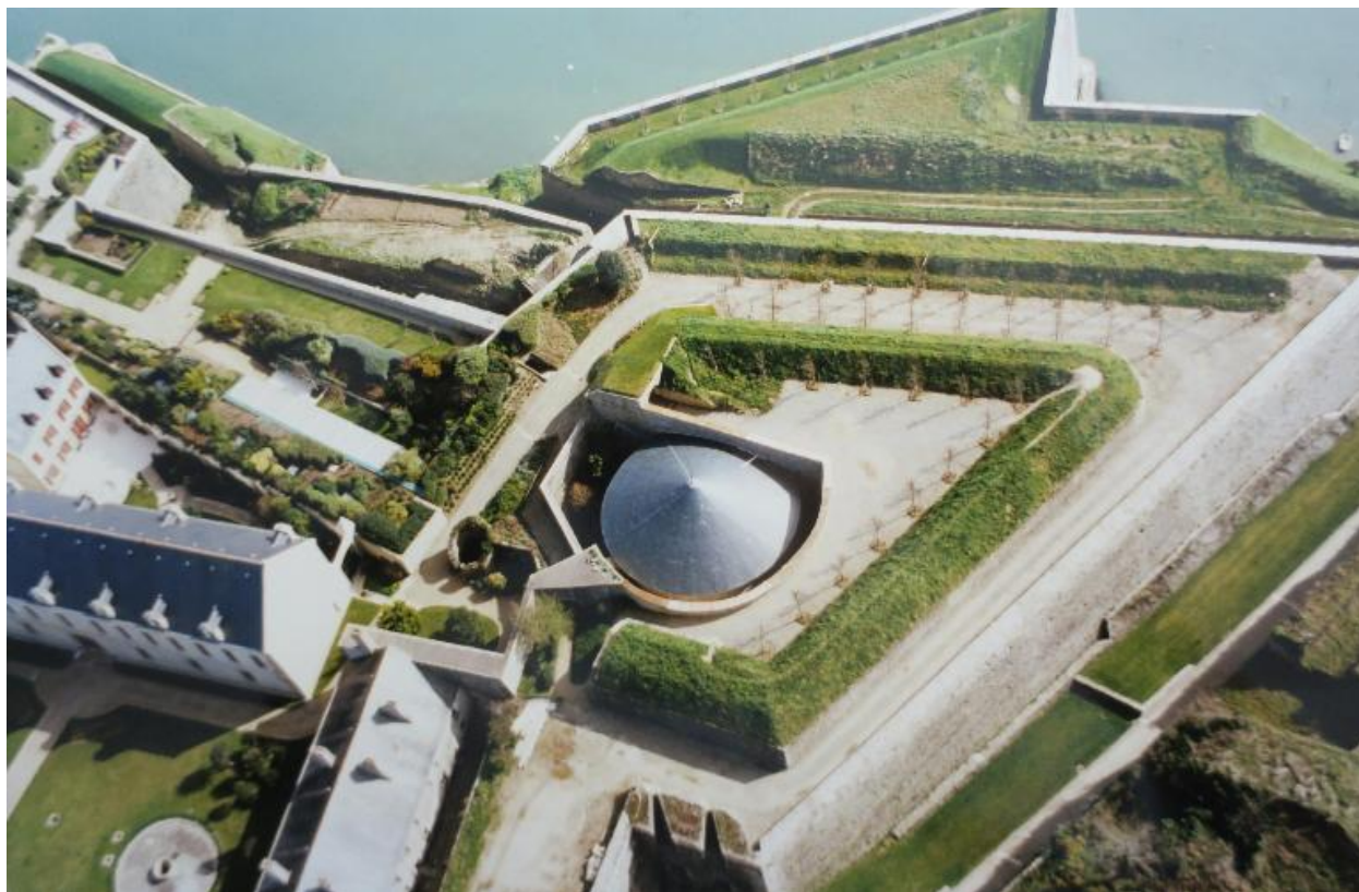
Le Palais, citadelle, cavalier du bastion 2, vue aérienne après la restauration.
