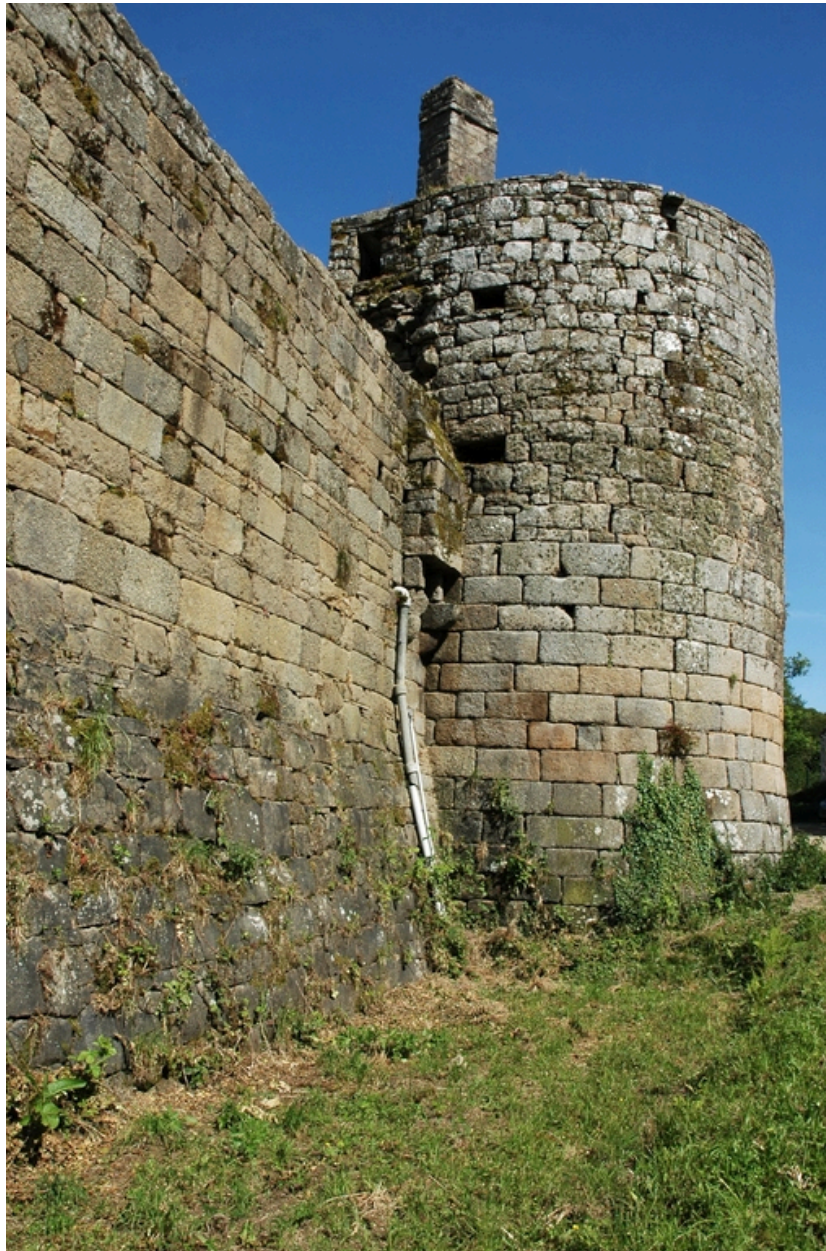
Vue de la barbacane : tour de plan circulaire flanquant la courtine. Dans l'angle : latrines en encorbellement
