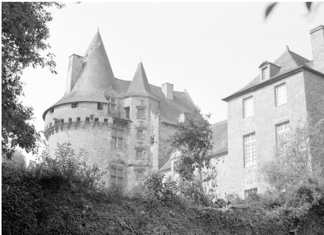
Vue générale prise du nord-est (état en 1984)
