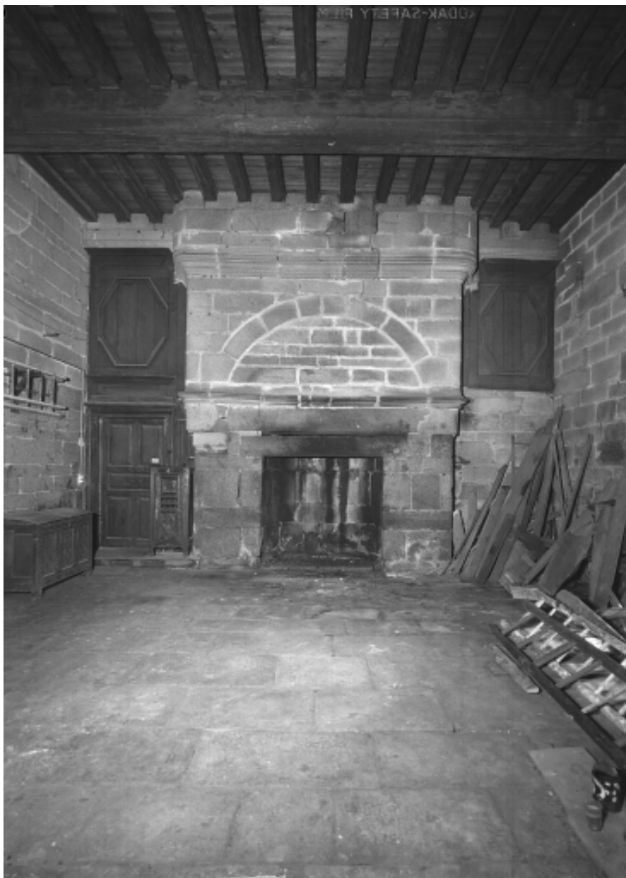
Rez-d-echaussée, grande salle (est) : vue générale de la cheminée
