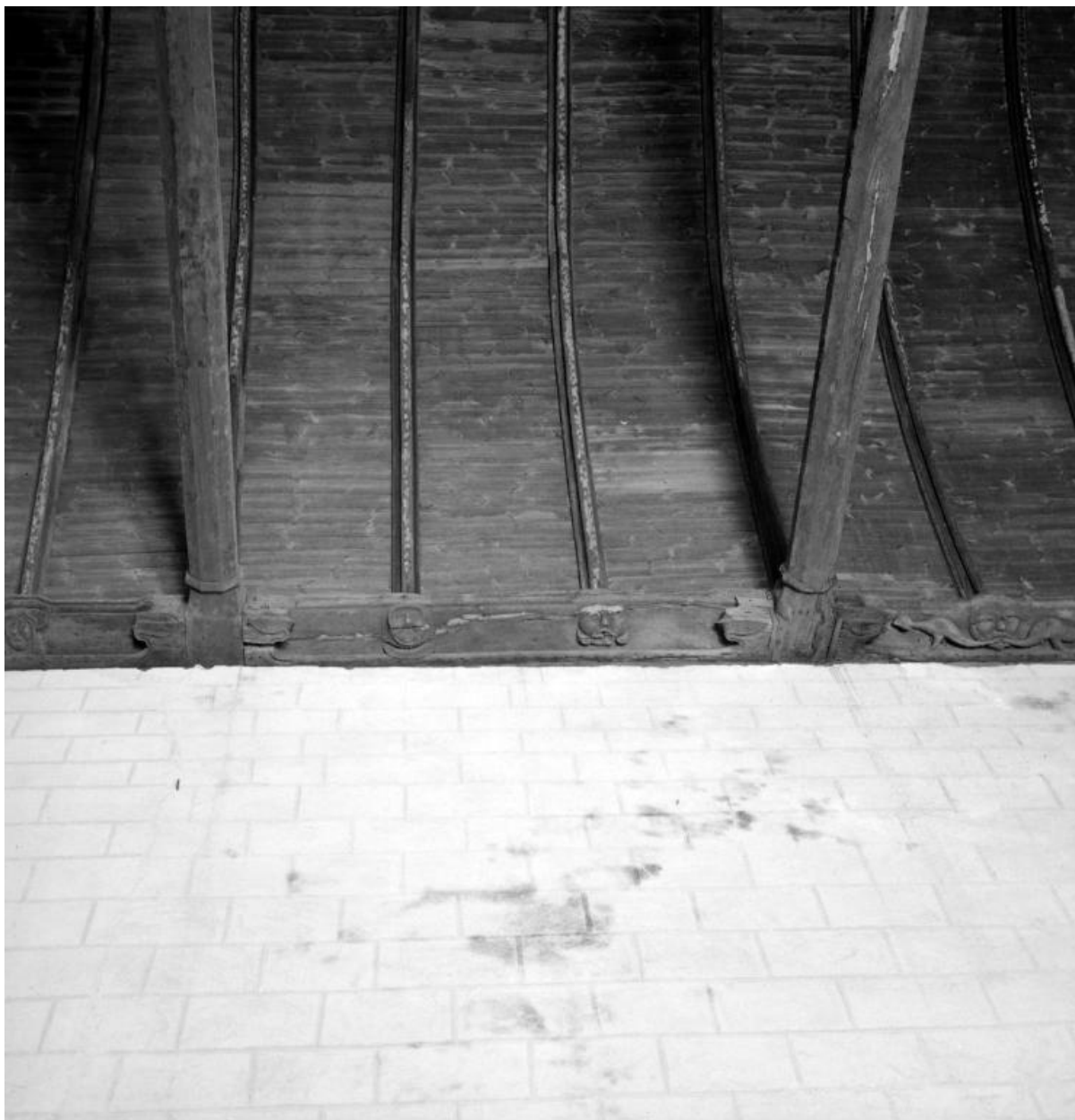
Sablères, détail du mur nord de la nef, entre entrails 2 et 3.
