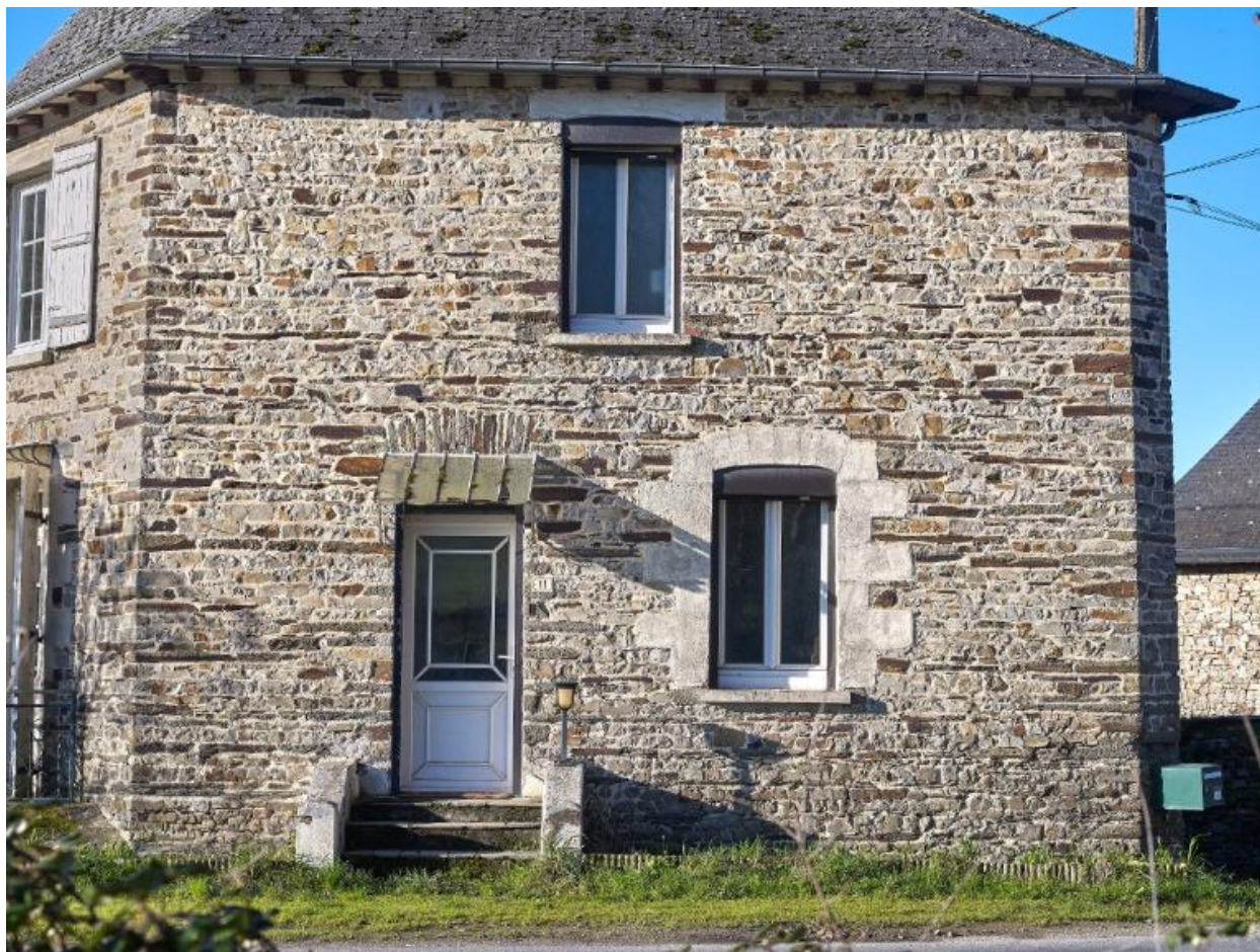
Façade côté route, 1 Roudun
