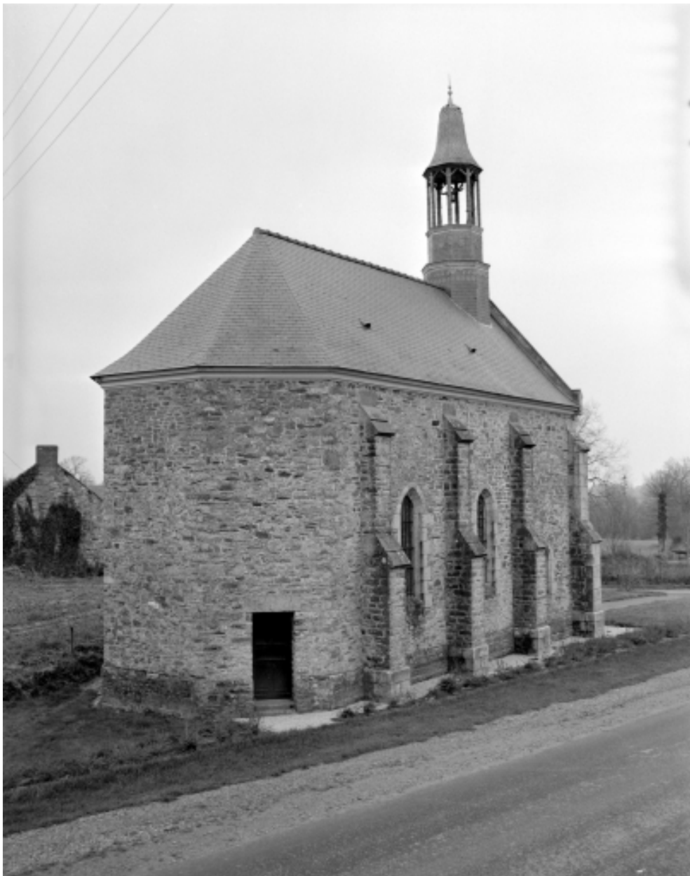
Elévation nord-est, chevet.
