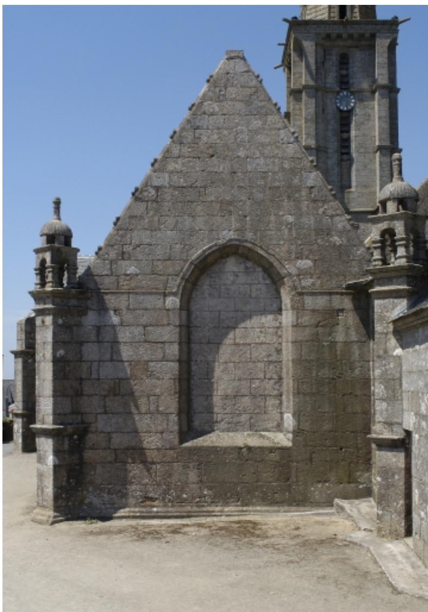
Bas-côté sud, pignon est
