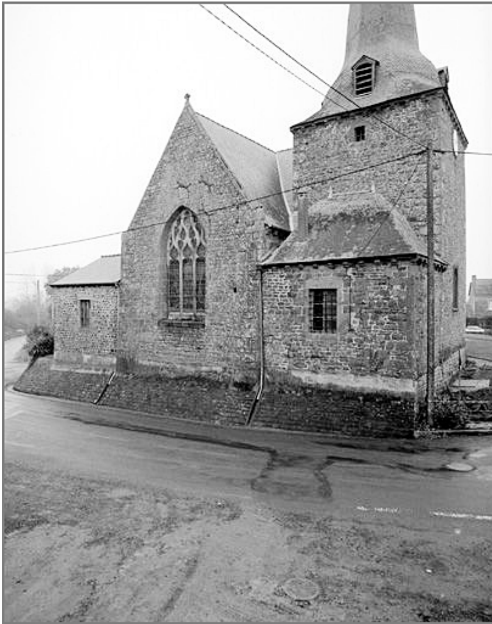
Elévation est : vue générale avant restauration
