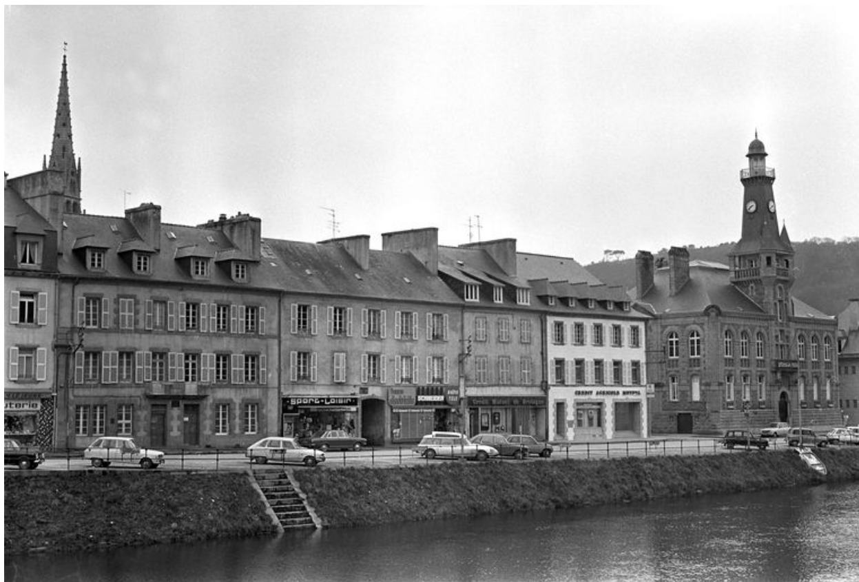
Quai Jean Moulin : vue générale
