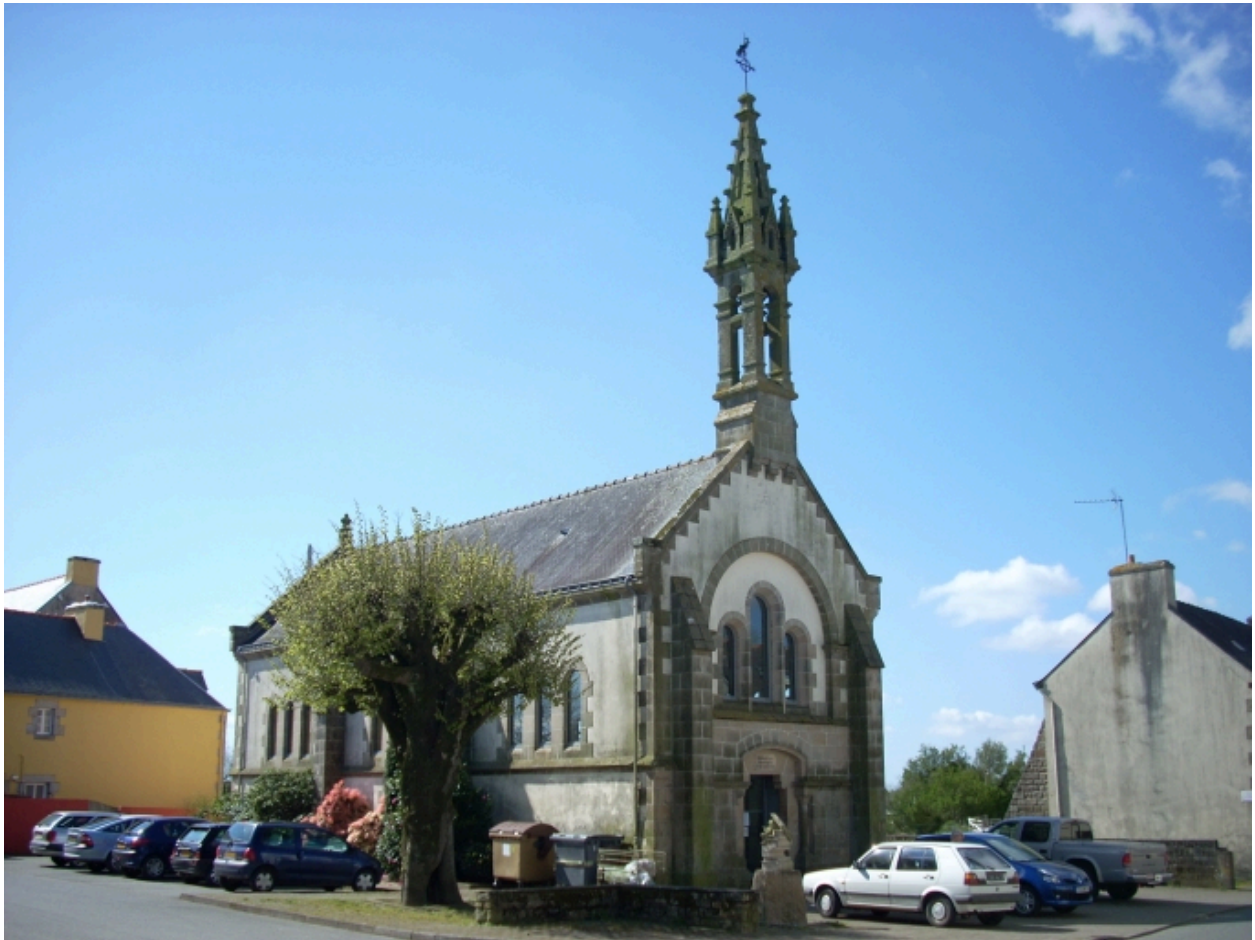
Querrien, chapelle Saint-Joseph : vue générale nord-ouest
