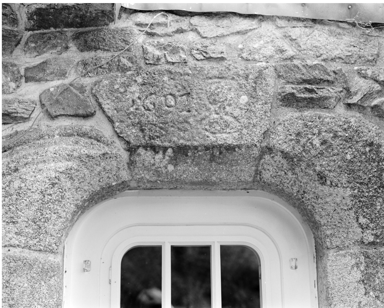
Le Pradigo, maison de prêtre, détail du linteau de la porte nord.
