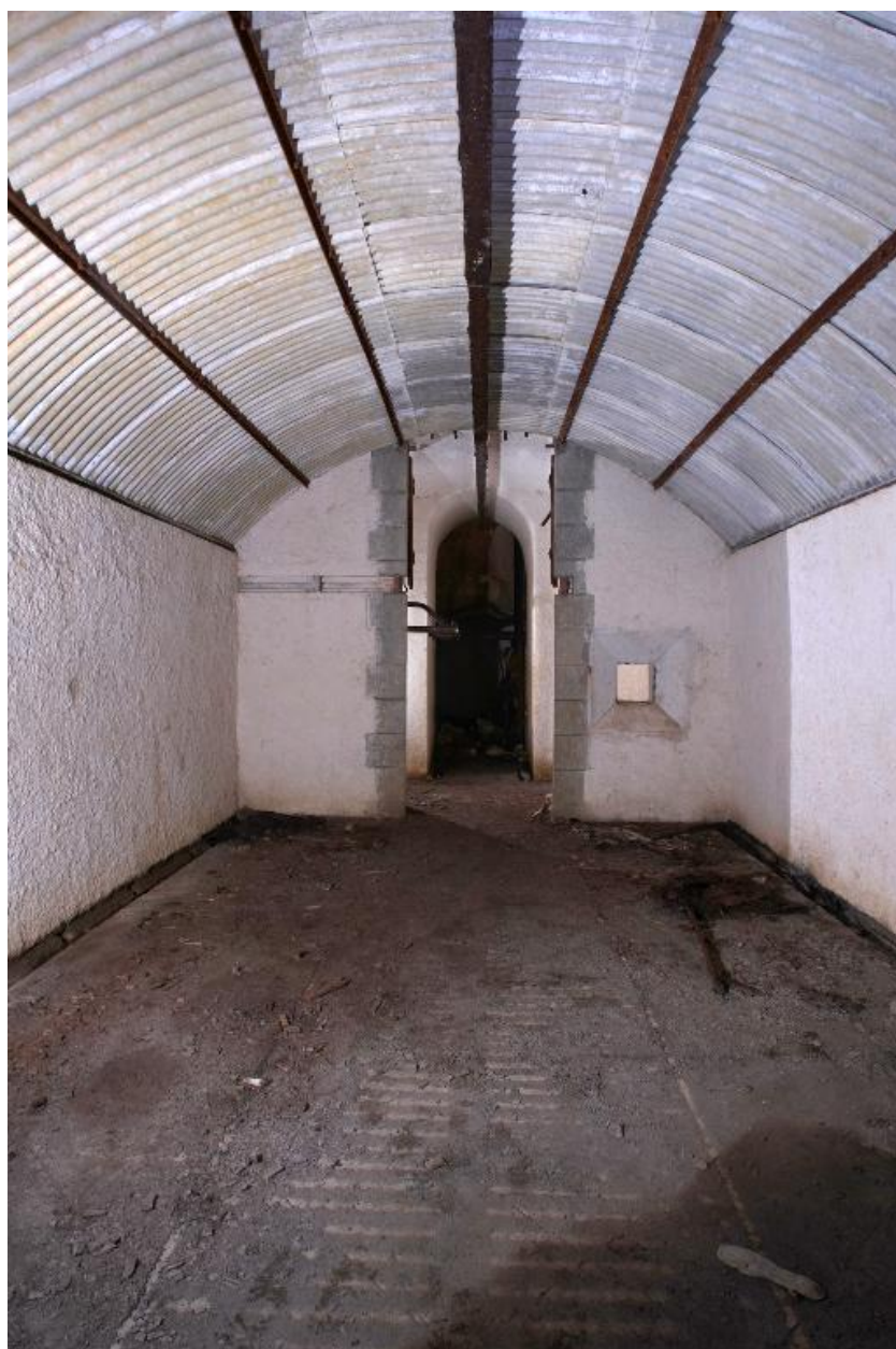
Camaret, pointe du Toulinguet : magasin à poudre sous roc (construction vers 1892)
