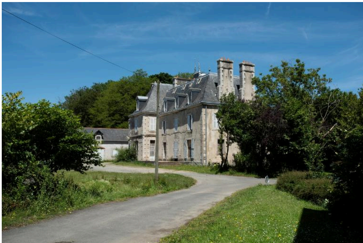
Maison de notable dite "château de Kerraoul", façade ouest.
