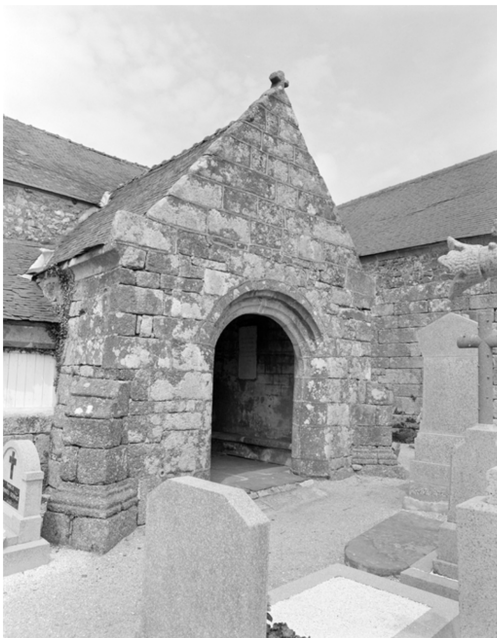
Vue du porche sud, prise du sud ouest
