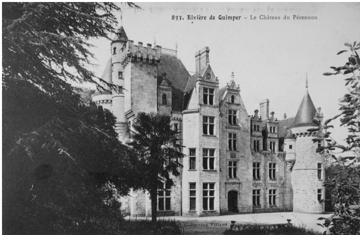
Vue générale de la façade principale
