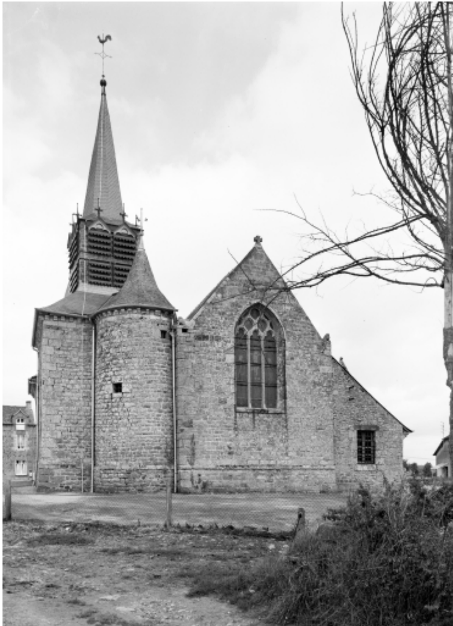
Elévation est : vue générale
