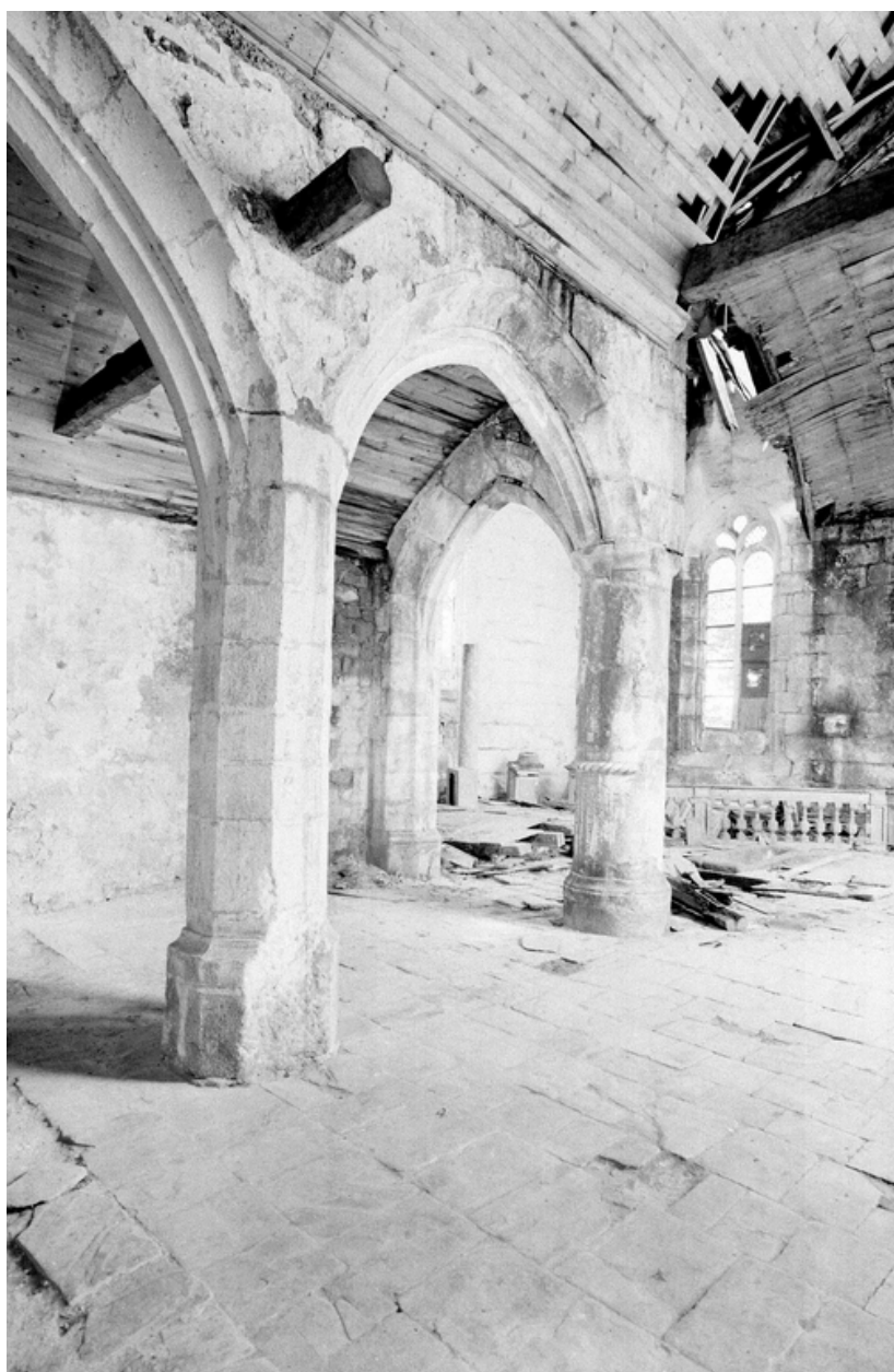
Vue de la dernière arcade de la nef
