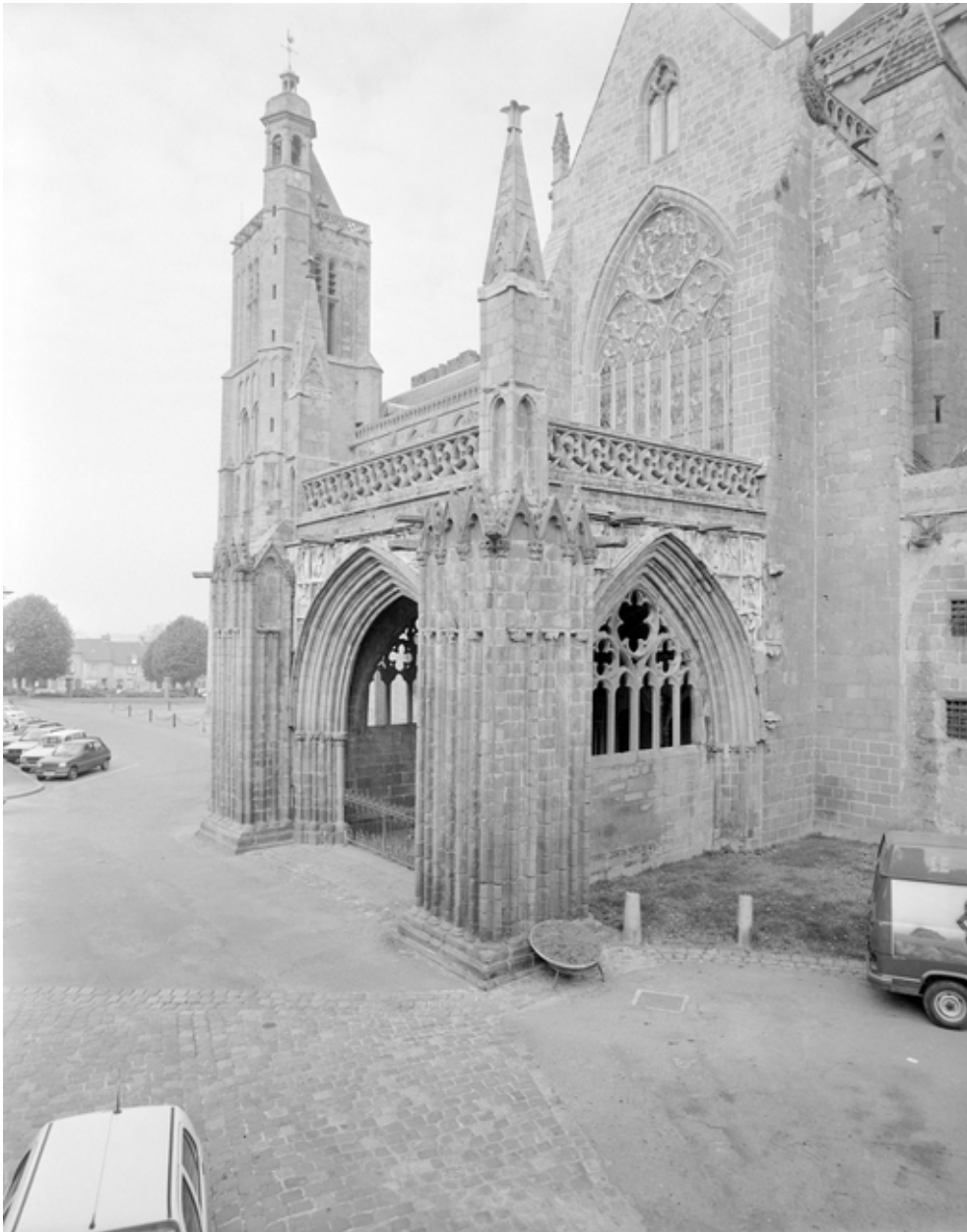
Grand porche : vue générale
