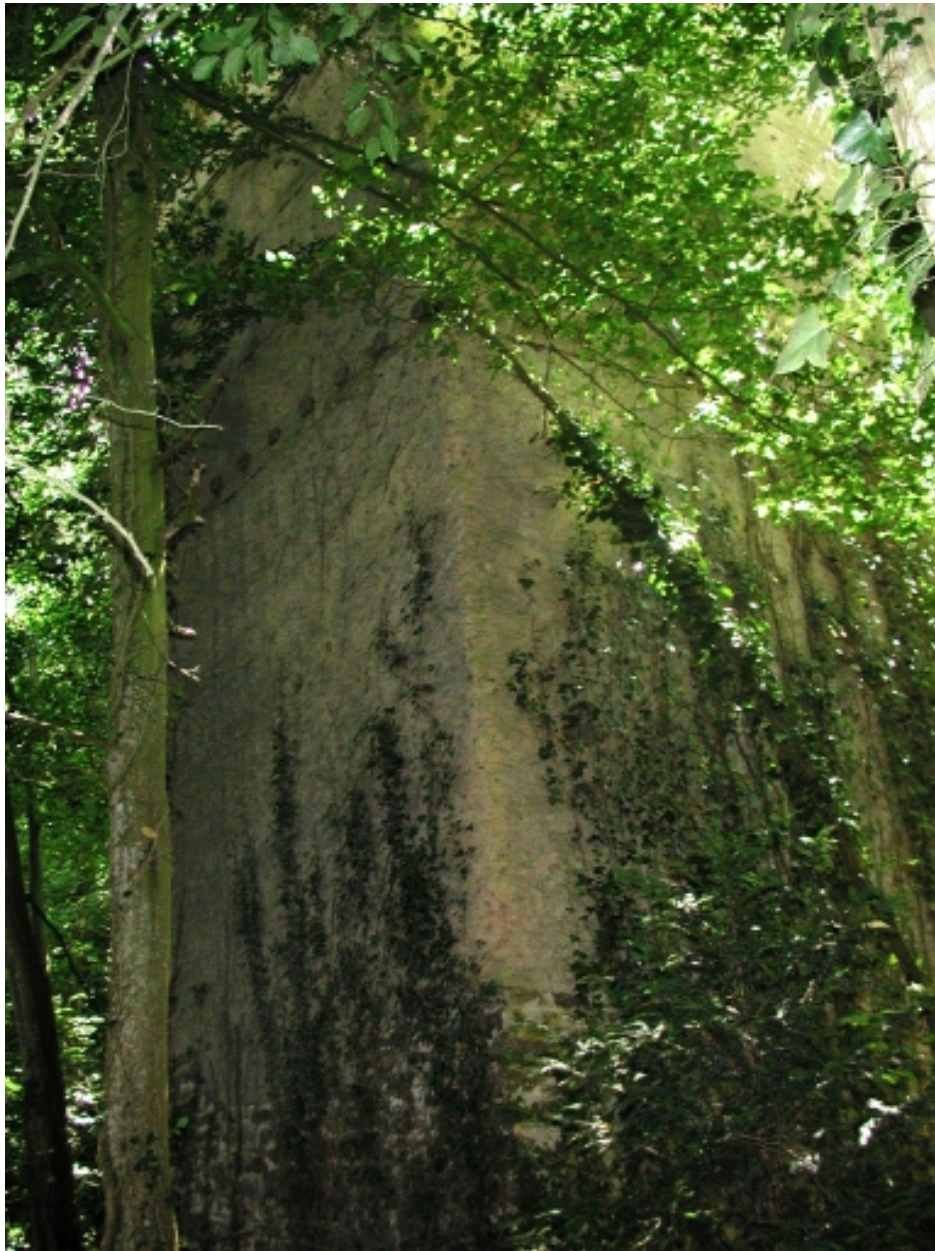
Tour quadrangulaire située au nord ouest
