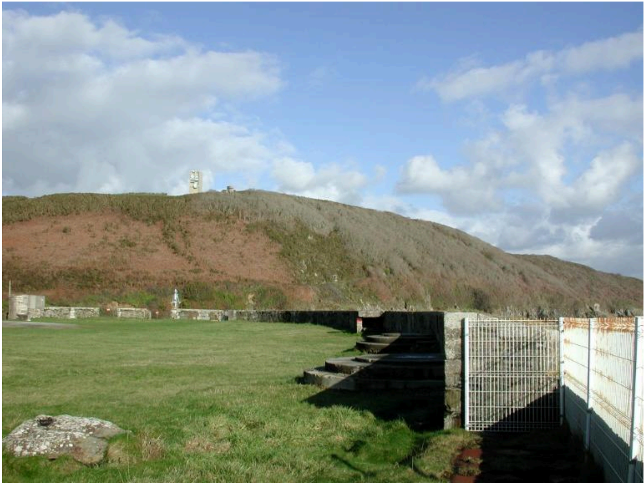
Vue de la plate-forme de la batterie basse du Mengant : ensemble de deux plate-formes en béton pour canon (état en 2003). Sur la hauteur, la tour de mesures de Kerdalaez
