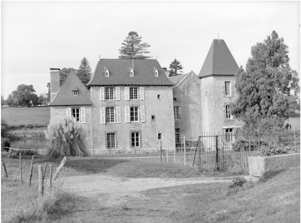
Château, vue générale nord-est.
