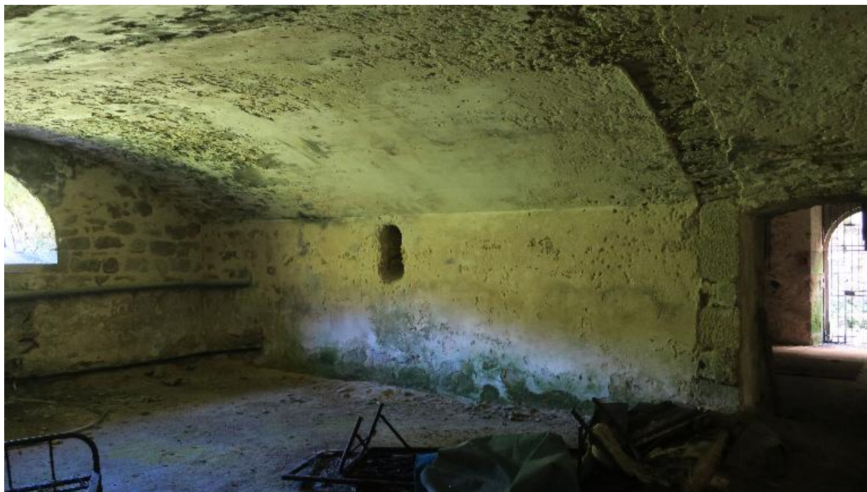
Hœdic, fort central, caserne à l'épreuve, casemate du sous-sol.
