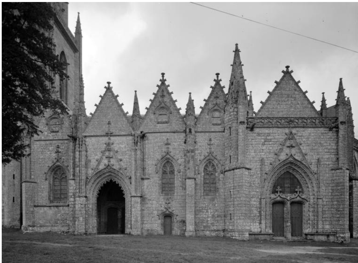
Façade sud, vue d'ensemble.
