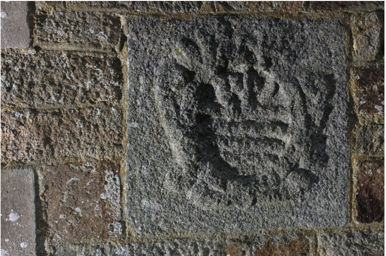
Elévation nord de la sacristie : détail d'un blason en réemploi de l'ancienne église
