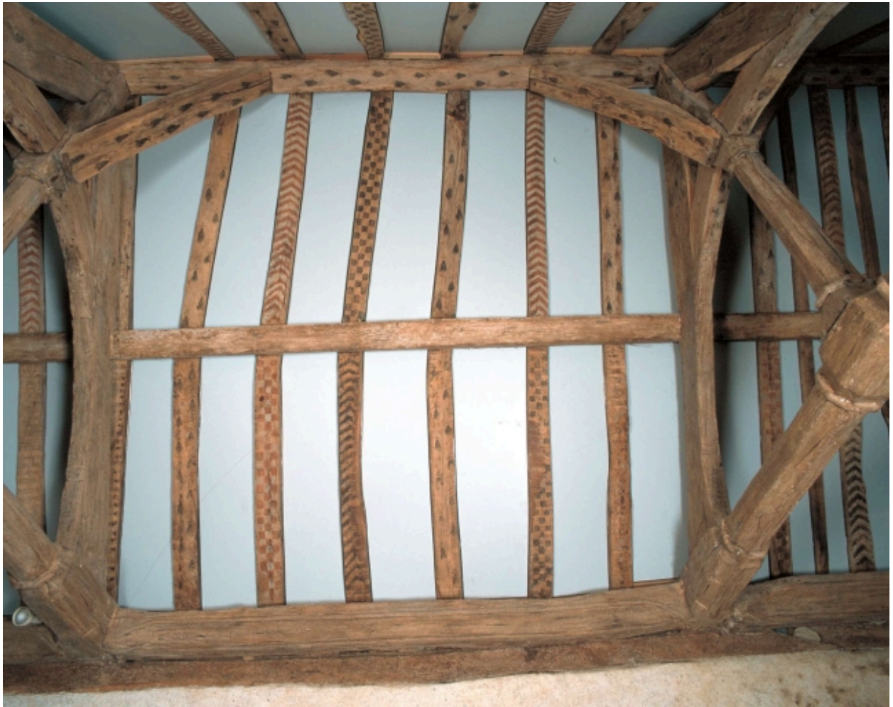
Intérieur : détail de la charpente
