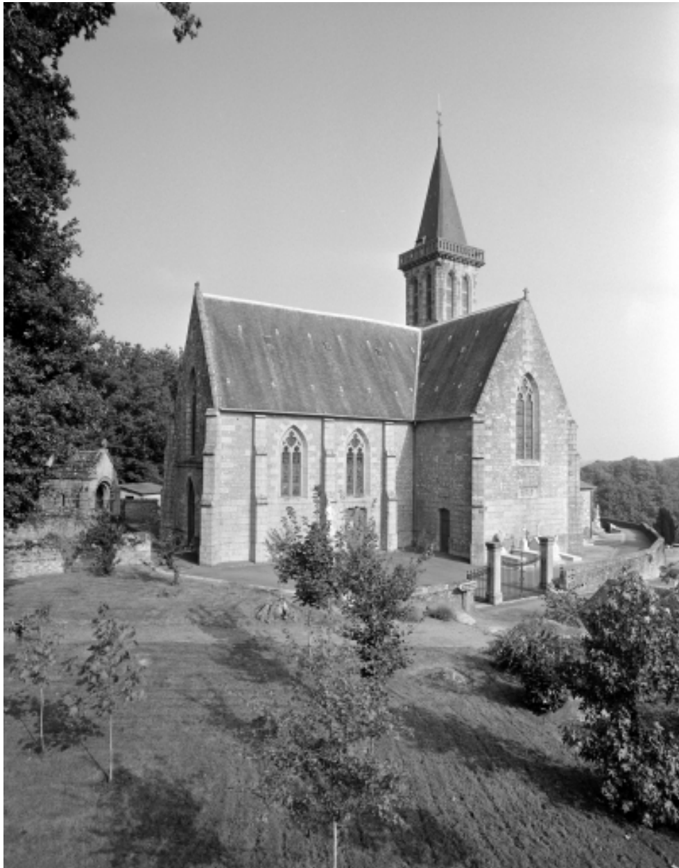
Elévation Sud-Ouest : vue générale
