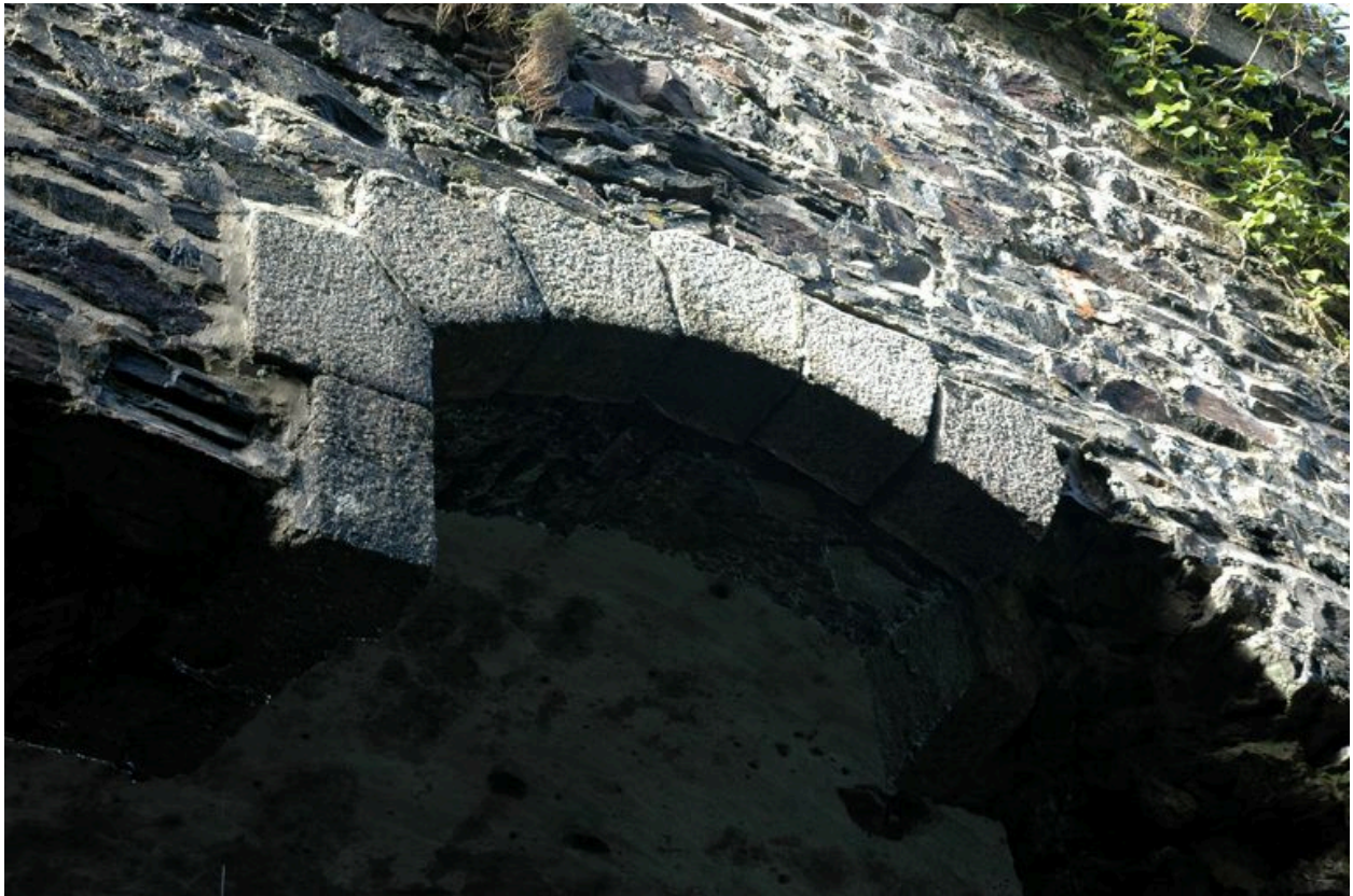
Vue de la caserne défensive Robert : façade postérieure
