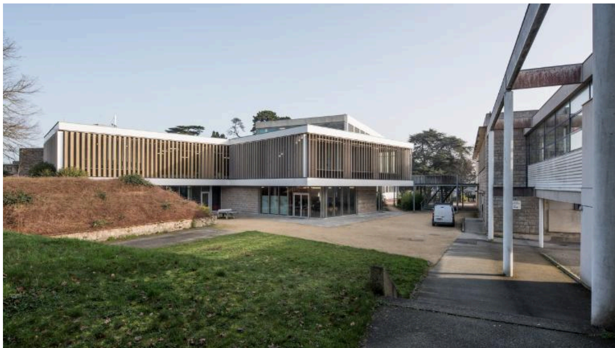
CDI, façades ouest et sud (Thierry Soquet, architecte, 2012). A droite, façade nord du restaurant pédagogique et passerelle vers les ateliers.
