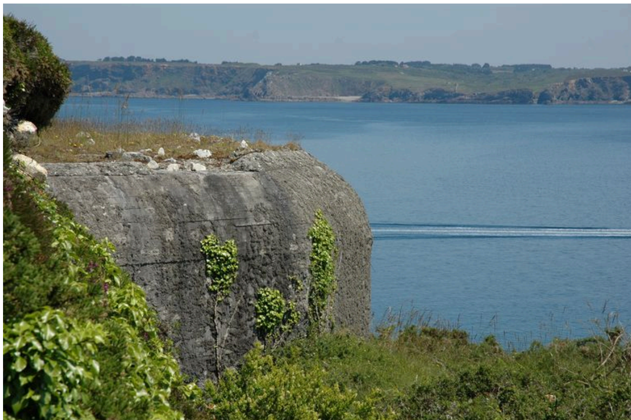
Vue de situation du bunker - casemate nord implanté sur la batterie de côte (état en 2005). En arrière-plan, la presqu'île de Quélern
