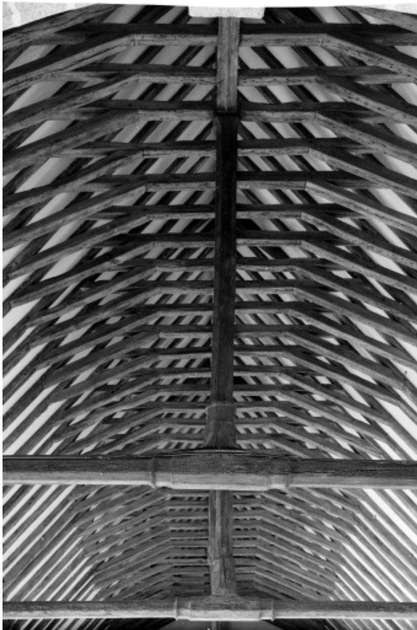
Intérieur, nef, charpente : vue générale.
