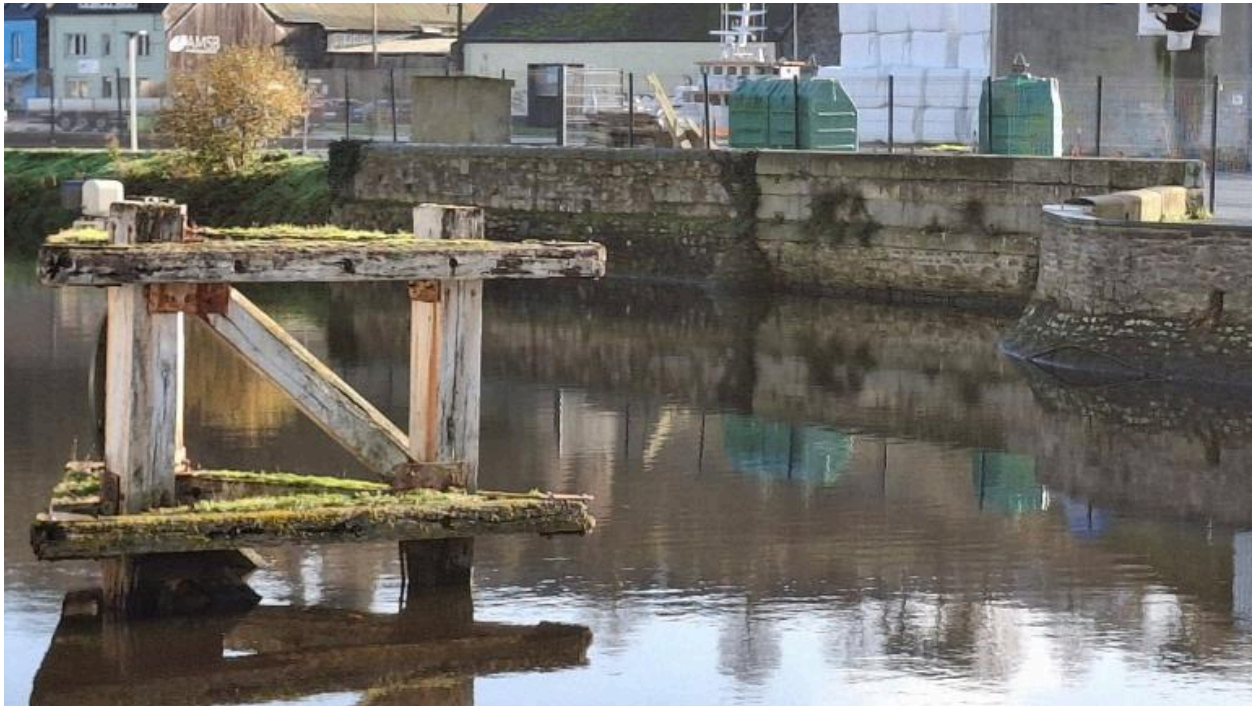
Quai maçonné entre culée du pont et pont du Gouëdic
