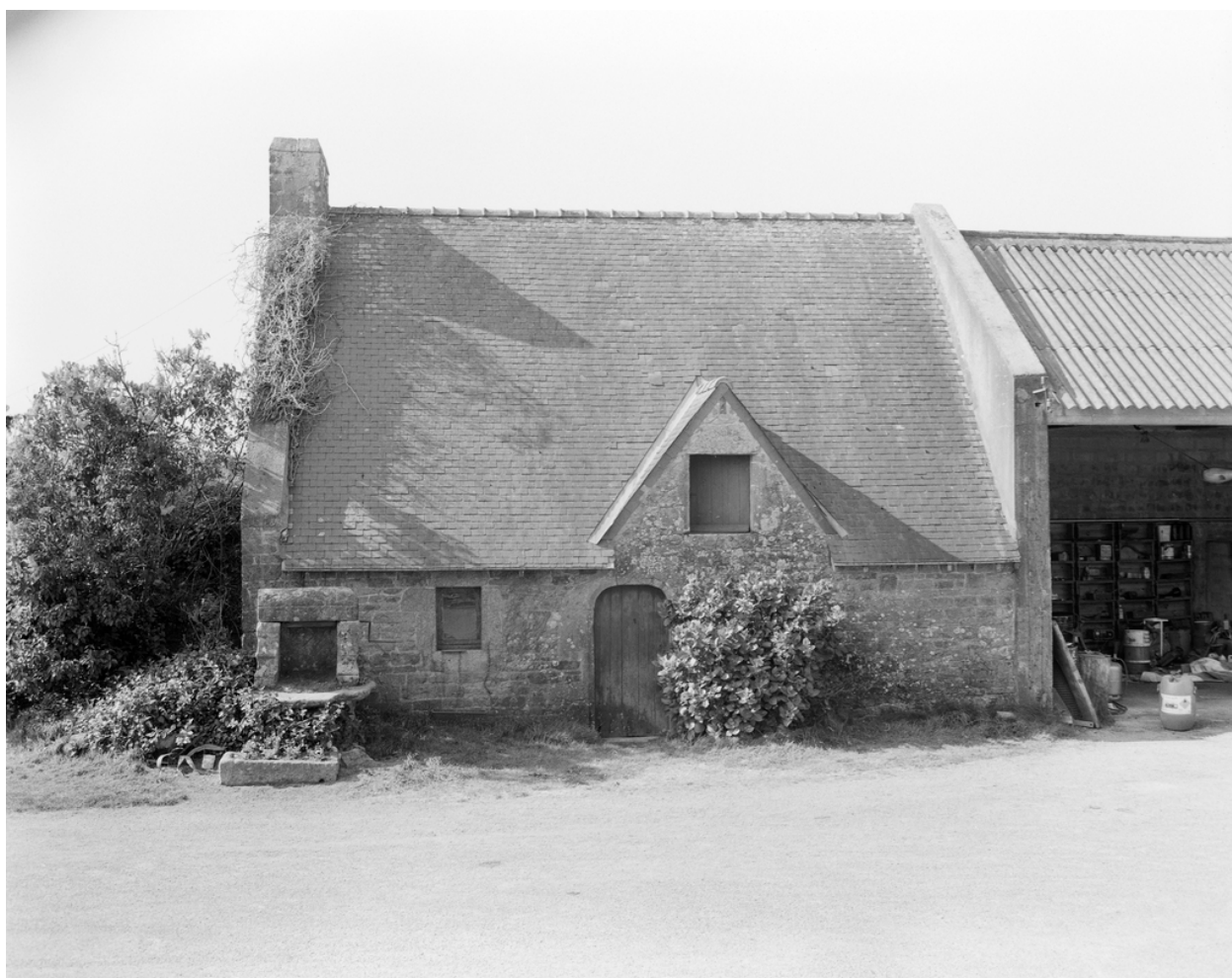
Kerledan : fournil et puits
