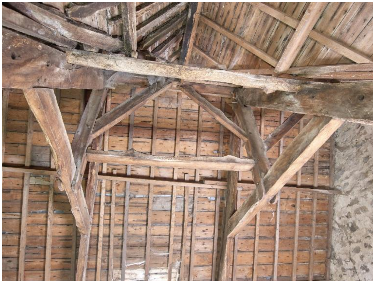
Charpente du logis sur rue.
