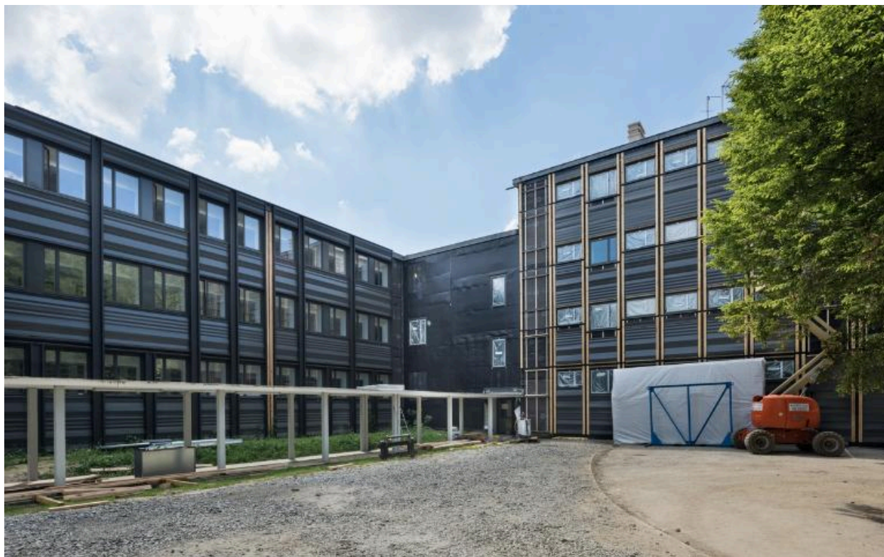
Travaux d'isolation extérieure, angle nord-est des bâtiments A et C. Groupe Legendre, architecte : Anthracite 2.0
