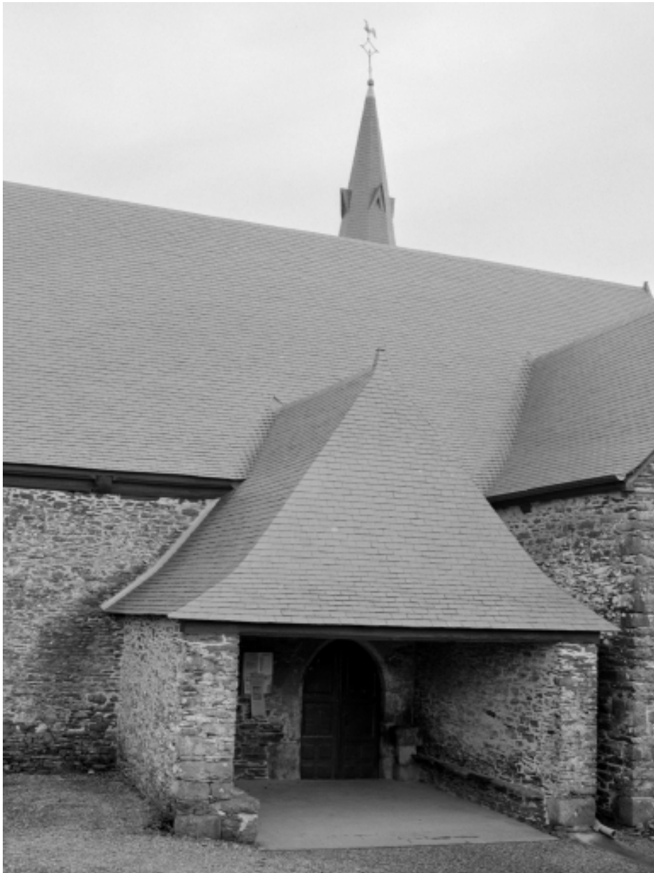
Elévation Sud, porte : vue générale
