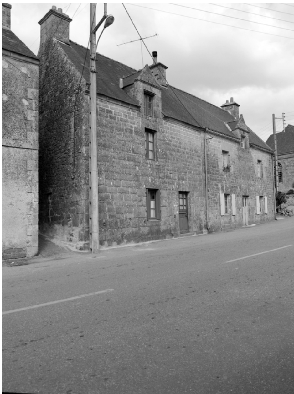
Bourg - Maison, vue générale des façades ouest.
