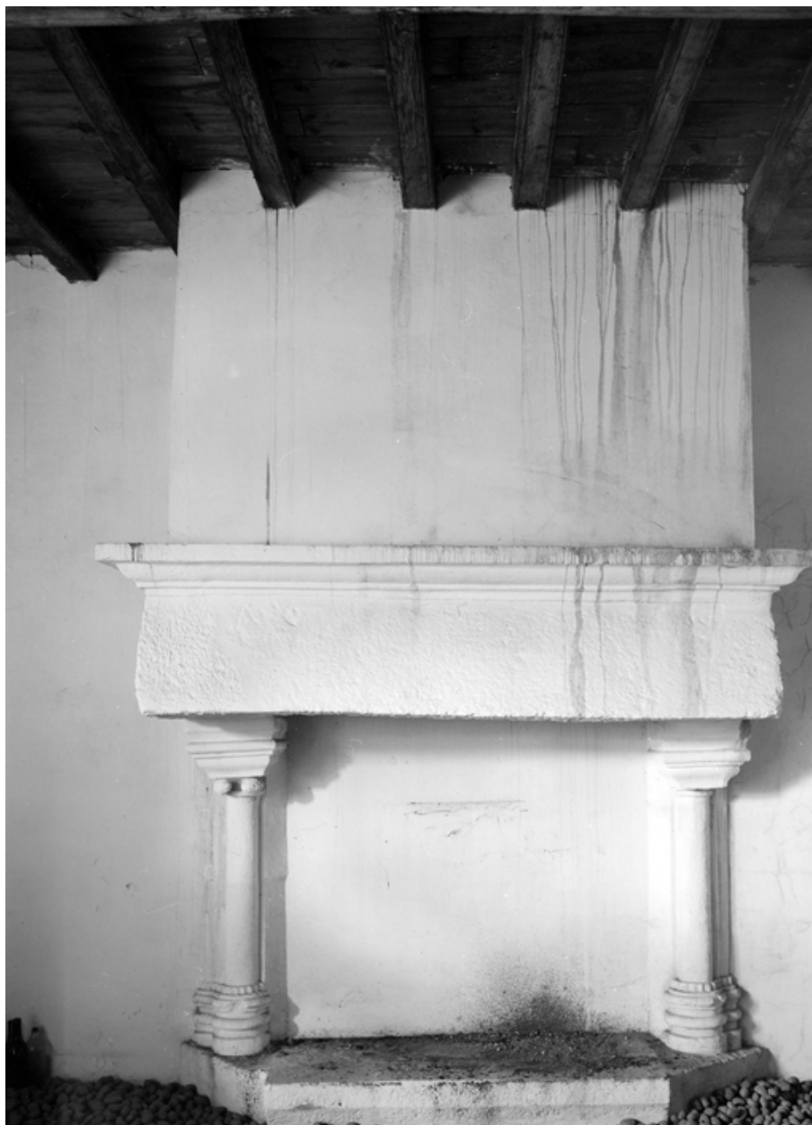
Cheminée du mur est au premier étage du manoir A.
