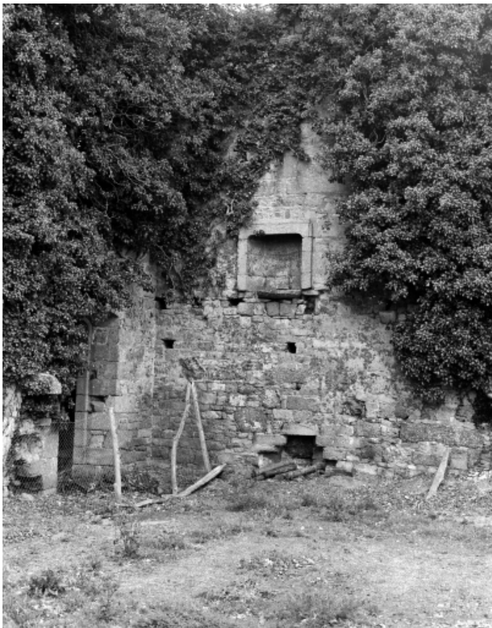
Logis, mur nord, cheminée
