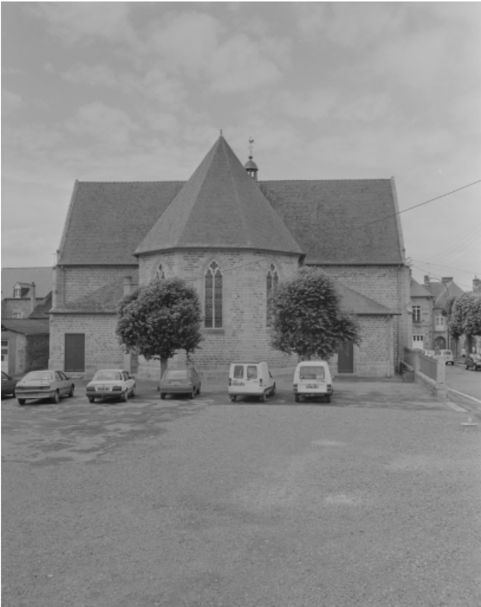
Elévation est : vue générale
