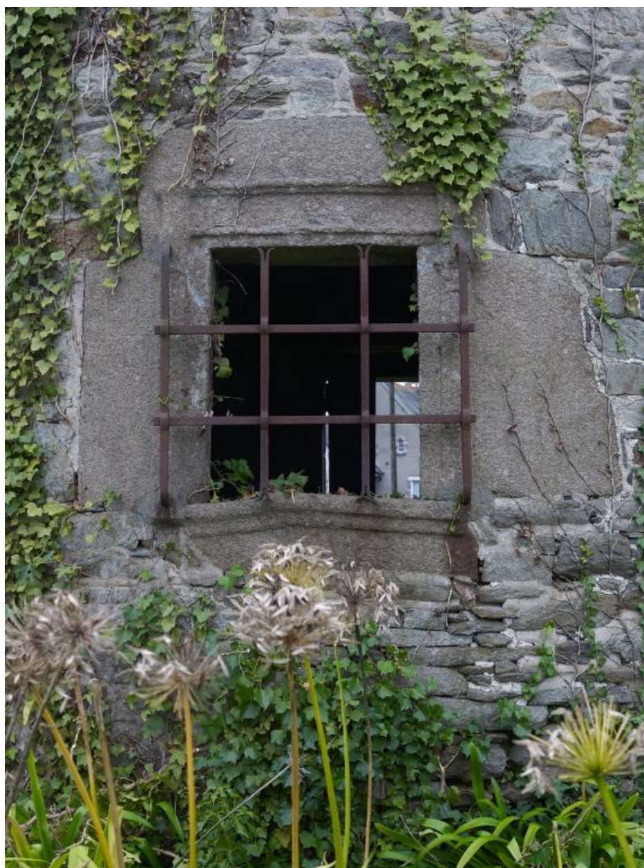
Vue de la fenêtre de la pièce du rez-de-chaussée.
