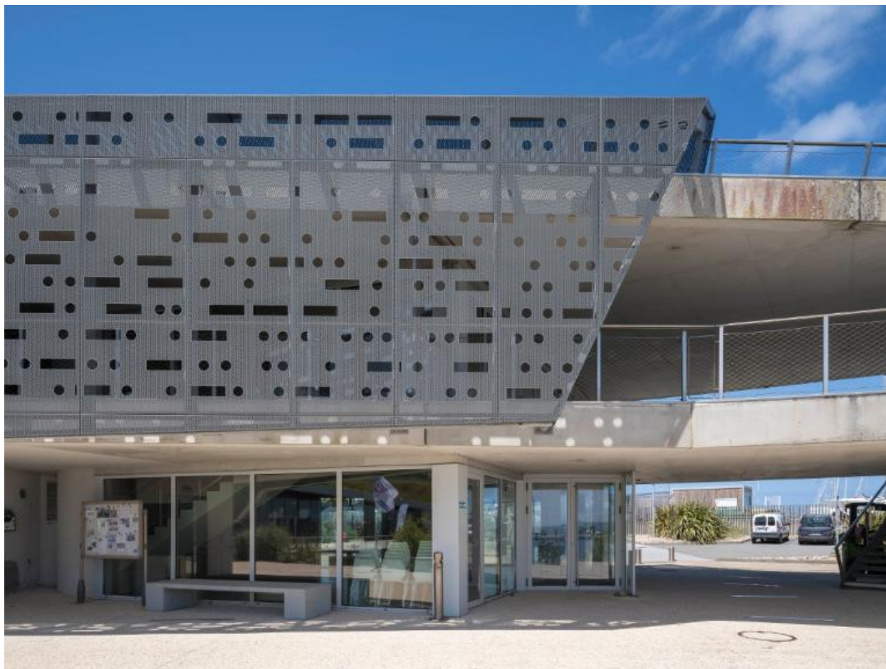
Espace commercial du port de plaisance de Roscoff
