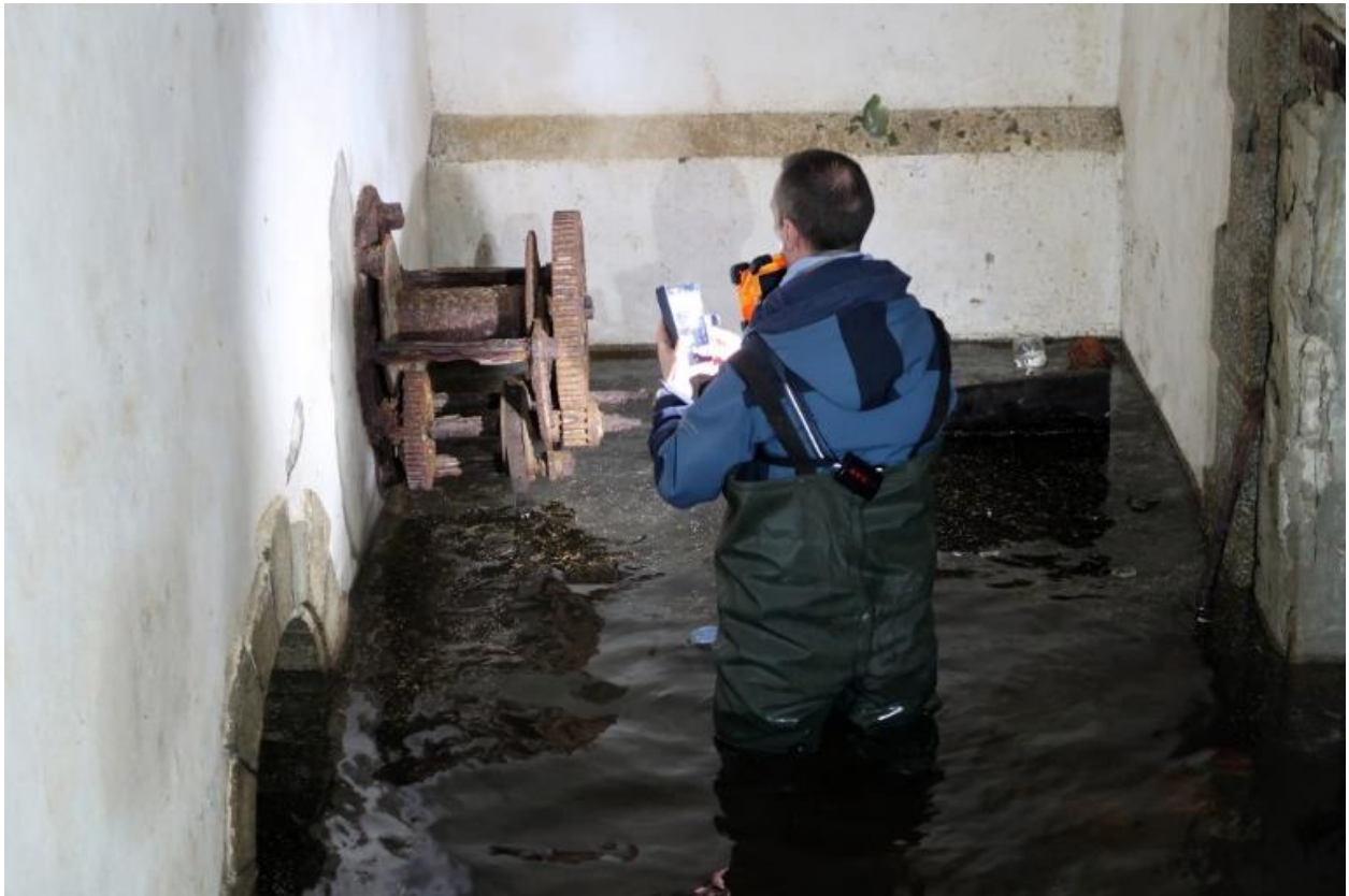
Vue du vestibule en partie inondée : dans l'angle, le treuil manuel à tambour pour la manutention des munitions ; à gauche, l'aqueduc ; à droite, le magasin
