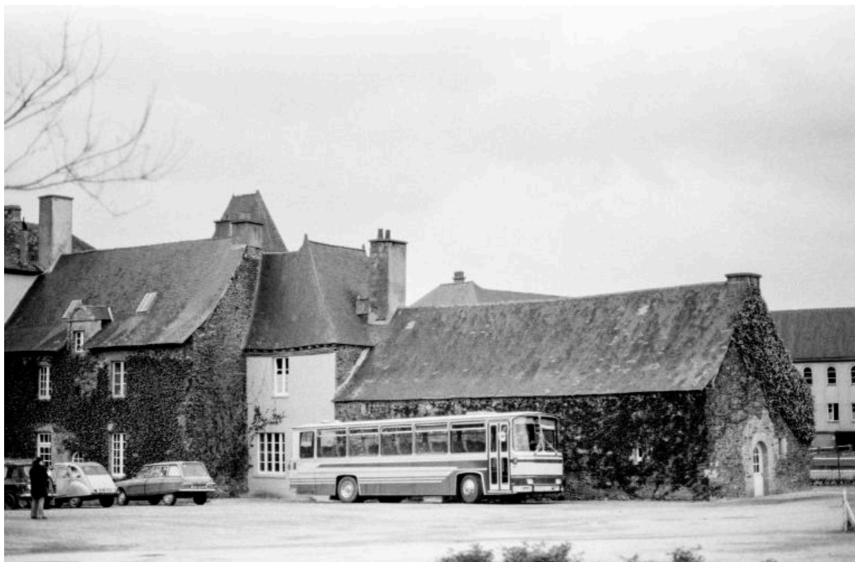
Vue sud-est (état en 1974)
