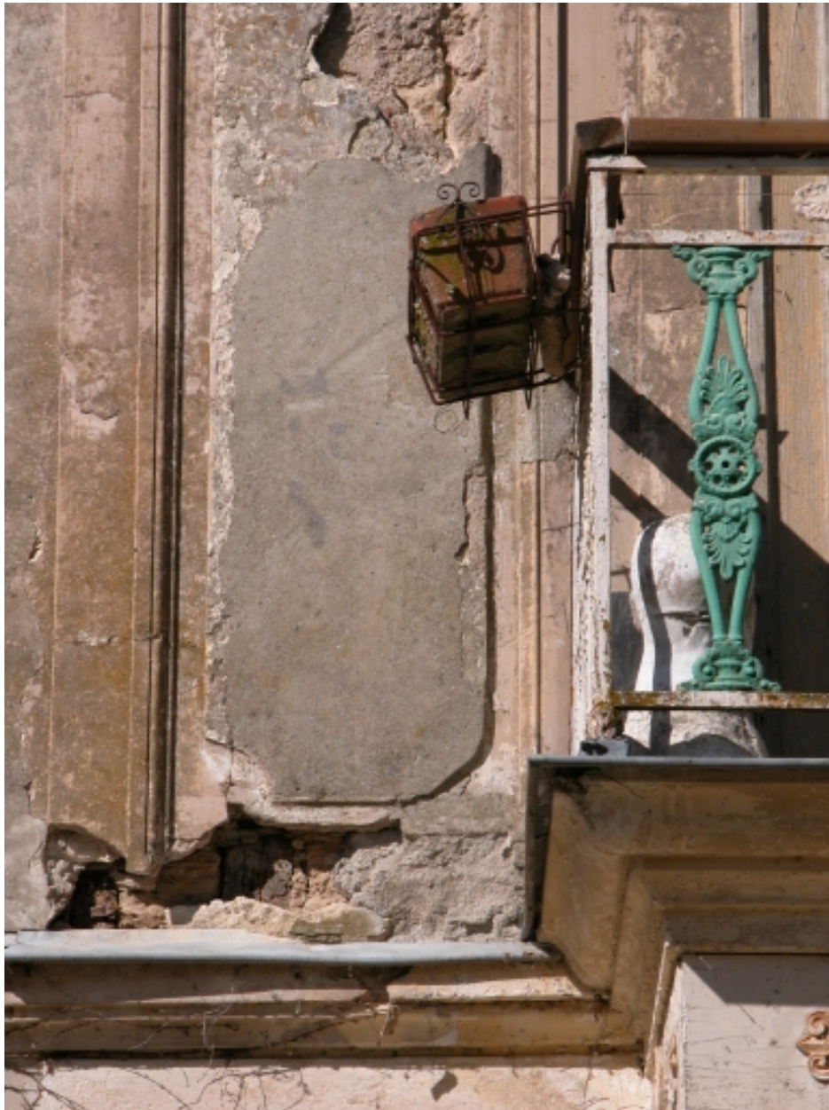
Détail sur l'enduit.
