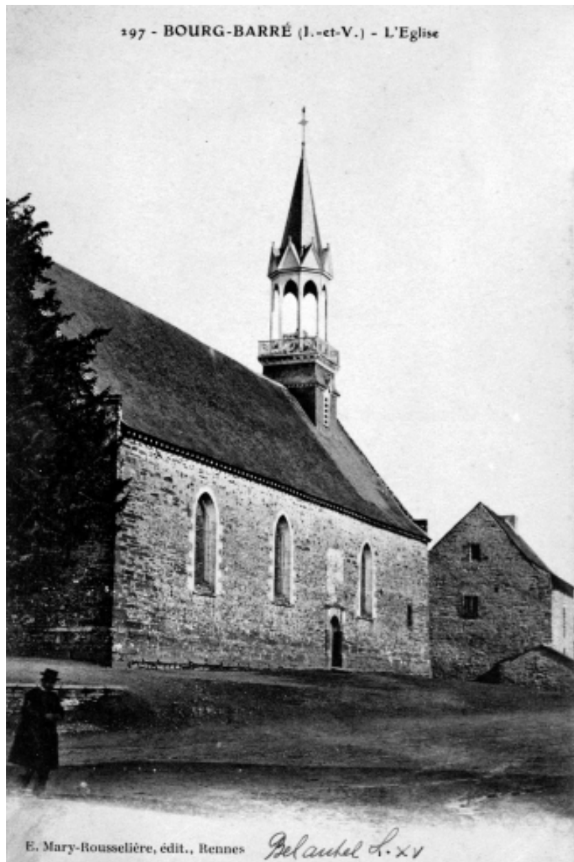
Elévation Sud : vue générale (Carte postale ancienne)
