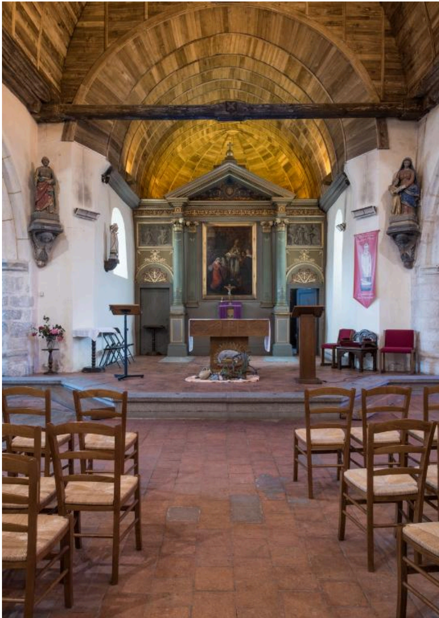
Vue du chœur et de la voûte lambrissée en chêne en plein cintre
