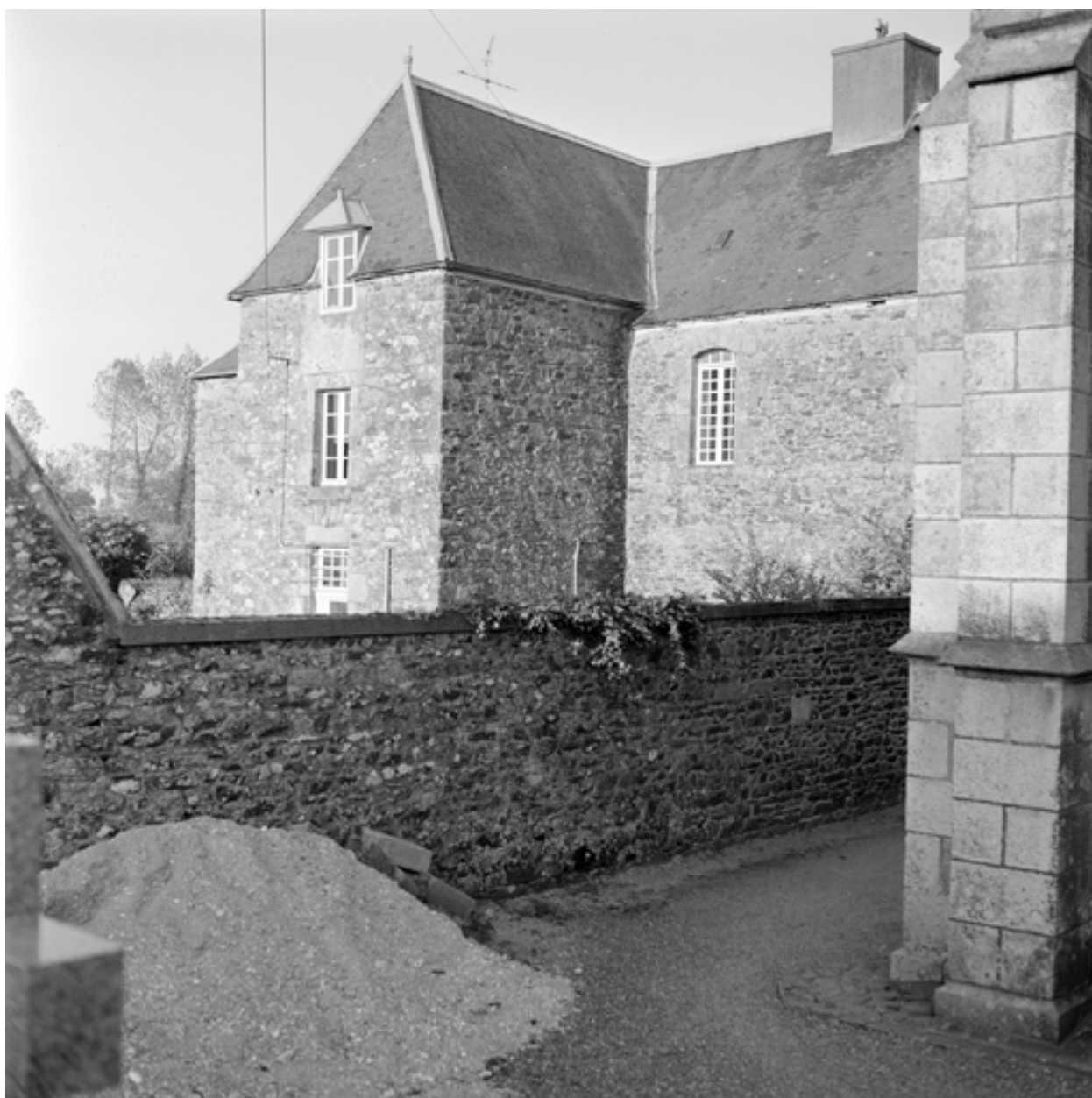
Façade ouest : vue générale (état en 1974).
