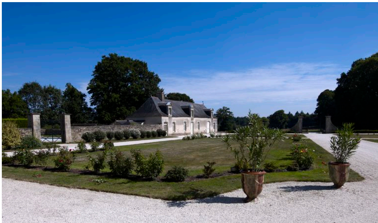
Château : le jardin, la dépendance nord et le portail (état en 2010)
